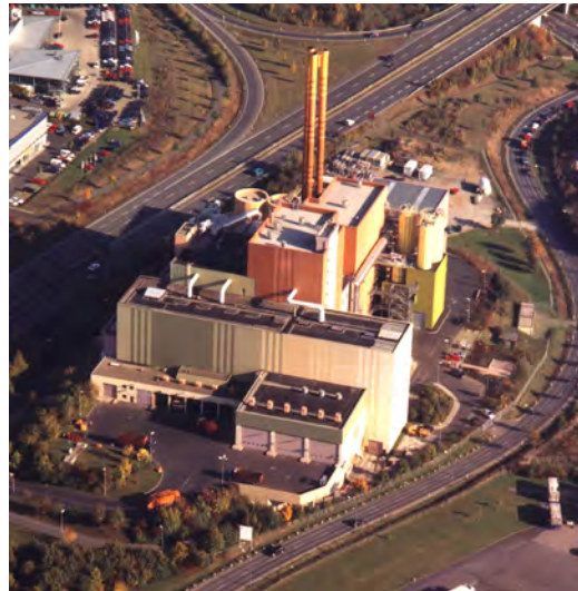
Müllheizkraftwerk des ZAK Kempten (links)
