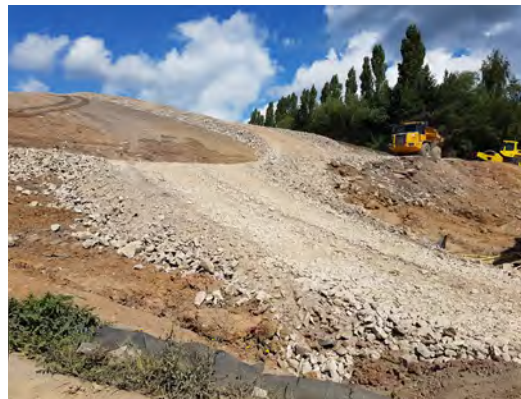
Deponiebetrieb und Oberflächenabdichtung auf der Deponie Cronheim (beide)
