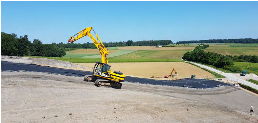
Aufbringung der Oberflächenabdichtung Deponie Cronheim
