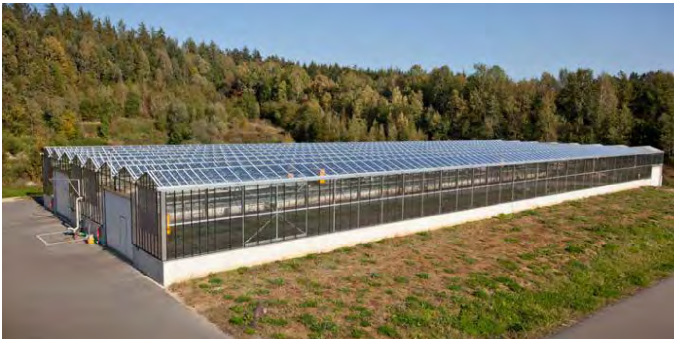
Trocknungsanlage Passau (ZAW Donau-Wald)
