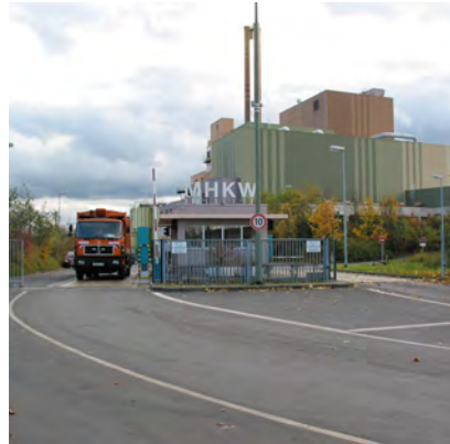
Müllheizkraftwerk des Zweckverbands für Abfallwirtschaft Kempten (links)
